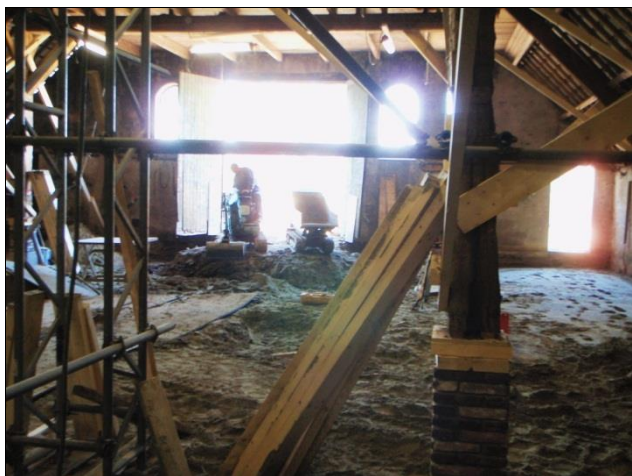
Afbeelding 14. Beeld van de start van de begeleiding van het uitgraven van het laatste deel van de stalvloer
