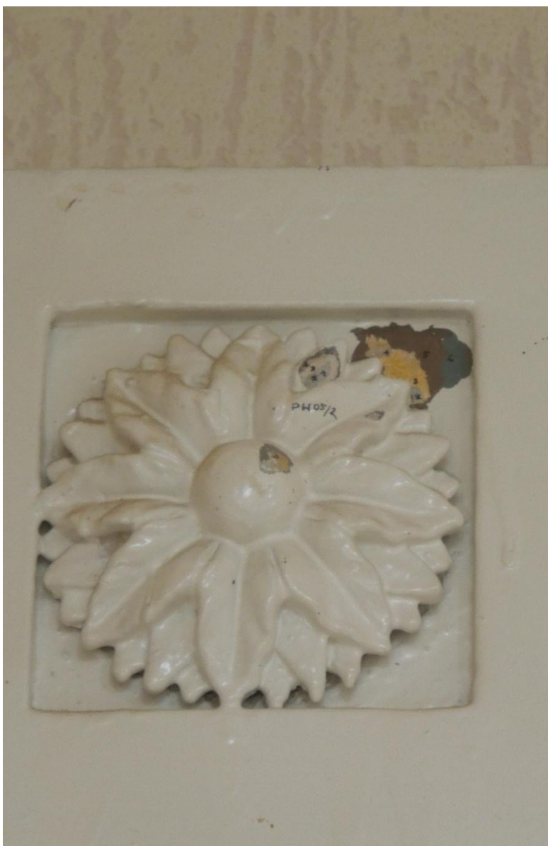
13 – kleurhistorisch onderzoek op het rozet (links) en deurstijl (rechts) van de kamer als op vorige foto getoond (19 de eeuwse uitbreiding van het poortgebouw).
