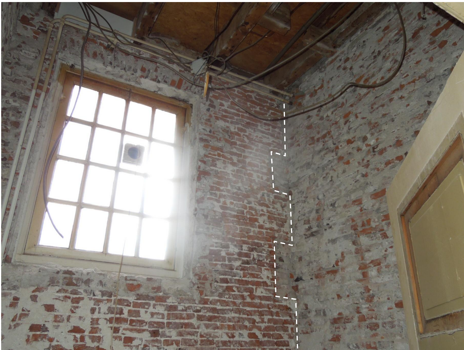
17 – ruimte P01.08 met zicht op een 19 de eeuwse venster in 19 de eeuwse metselwerk. De wand rechts op de foto dateert uit 1915 en is middels een bloktand met het 19 de eeuwse metselwerk verankerd.
