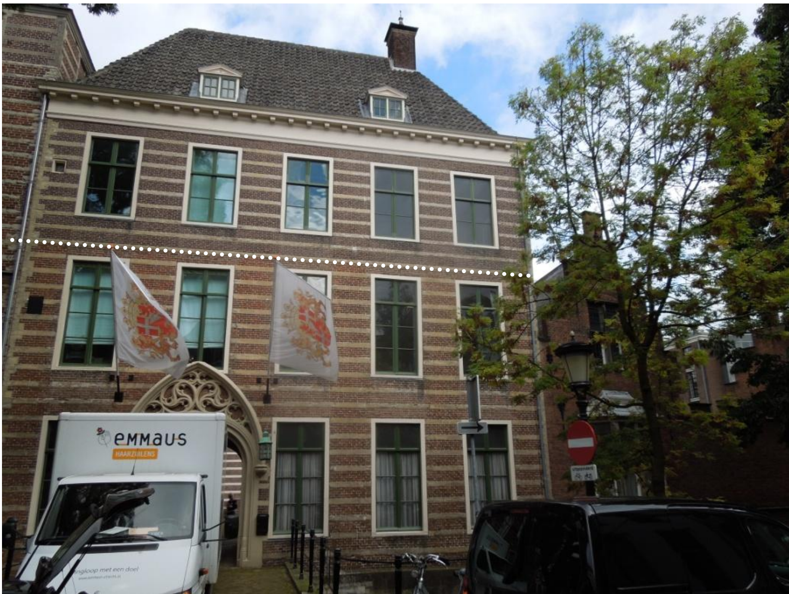
9 – foto van de gevels van het poortgebouw en de dienstwoning (verscholen achter de bomen, rechts), grachtzijde. Ter hoogte van de stippellijn is een duidelijk verschil in metselwerk te herkennen. Verder is ook te zien dat de kozijnen zijn vernieuwd, inclusief aangrenzend metselwerk. Ter hoogte van het nieuwere metselwerk zijn de horizontale spekbanden niet van natuursteen, maar zijn deze gepleisterd. Ook het gevelmetselwerk tussen de vensters op begane grond en verdieping is verstoord. De poort is nog voorzien van de oorspronkelijke natuurstenen omlijsting met gotische motieven.
