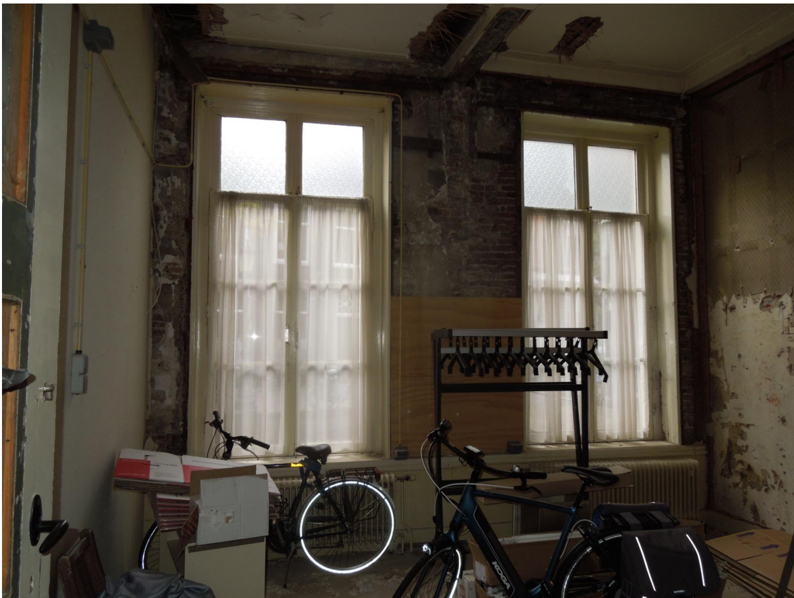
11 – kamer grenzend aan de gracht, rechts van de poort. De ruimte vertoont diverse bouwsporen: de rechter wand is voorzien van een papier behang, waarna regelwerk is angebracht ten behoeve van een wandbespanning. Met metselwerk tussen de twee vensters laat zien dat hier een wand heeft gezeten die in 1959 is verplaatst naar links op de foto. De ruimte kent ongelijke plafondhoogtes, van elkaar gescheiden door een moerbint die van gevel naar binnenmuur loopt. Op de moerbalk zijn kinderbinten gelegd. Eenzelfde samengesteld balkenplafond boven een stucplafond zien we ook op de verdieping terugkomen.
