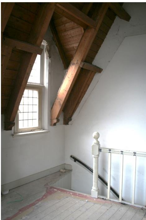
Origineel raamkozijn en balustrade van trap
