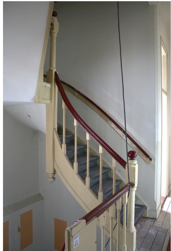
Trappenhuis, eerste verdieping
