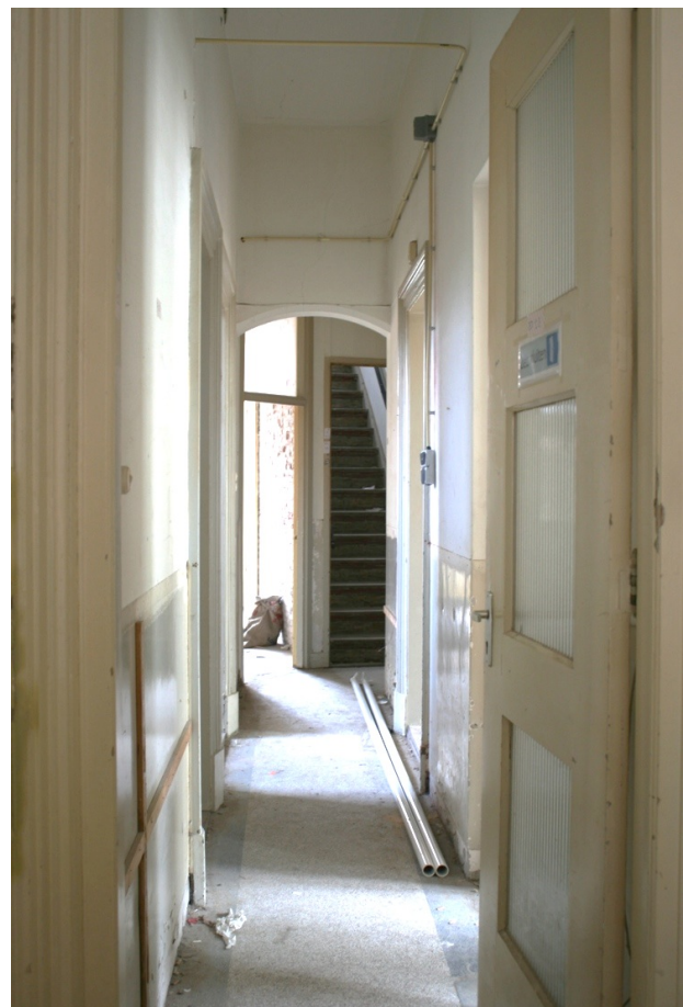
De gang gezien vanaf de voordeur. De trap voorbij de boogvormige doorgang hoort bij de dienstwoning
