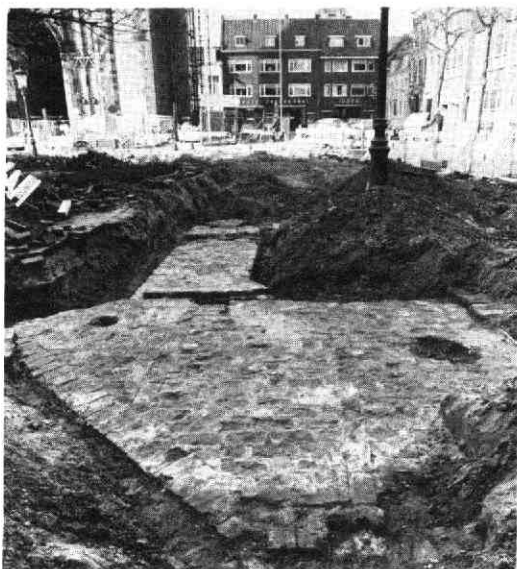
Afb 20. Domplein e.o. Breed aangelegde fundering van een pijler van de Domkerk.
