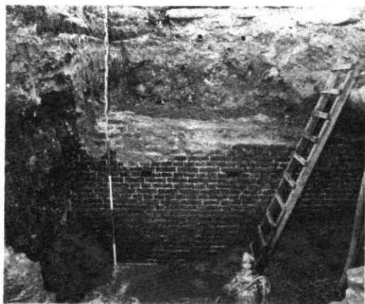
Afb 39. Mariaplaats. Oostelijke kademuur van de sloot van St. Marie. De gemiddelde waterhoogte van de sloot bevond zich op de scheiding van de witte en de donkere voegen. Het metselwerk is zeer regelmatig. Links en rechtsonder is nog net de westelijke kademuur zichtbaar.
