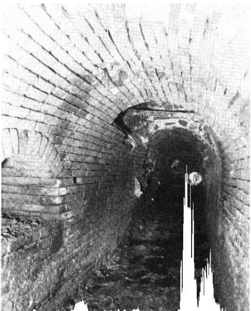
Afb 16. Breedstraat 50. Middeleeuwse slokop gezien van de Breedstraat naar het noorden. Links een zij-inlaat.
