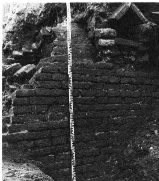
Afb 21. Domplein e.o. Gemetseld riool van ruim 1.60 m hoog met een overlaat op de hoek van de Voetiusstraat en Achter St. Pieter.
