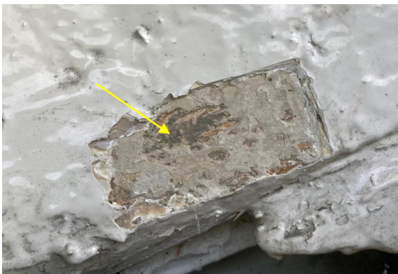
Sondering op houten lijst van timpaan. Eerste afwerklaag midden-grijs (pijl), gevolgd door lichter grijs en daarna gele fase (hier niet zichtbaar)
