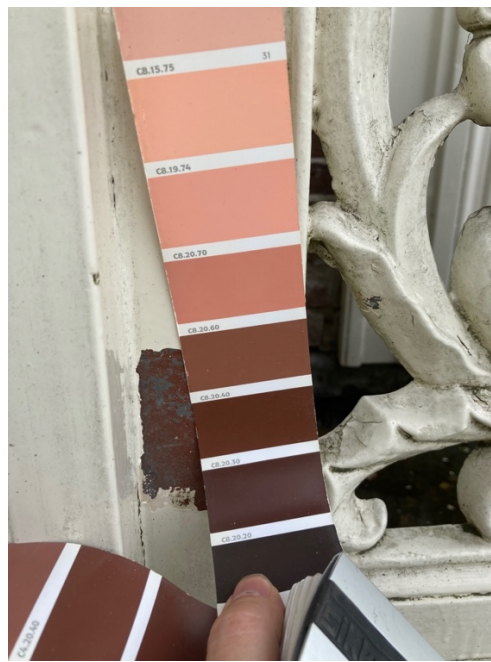
Roodbruine menie- of verflaag (ca C8.20.60 )
