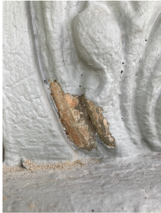
Sondering op bladmotief van kapiteel; restanten van gele en bruinige lagen gevolgd door grijs
