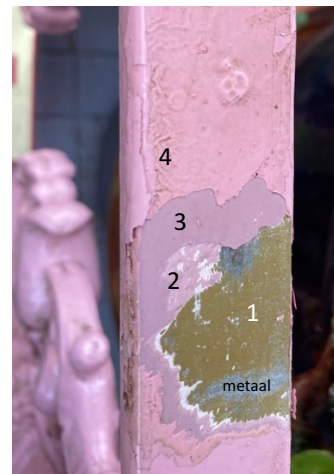
Sondering op railing
