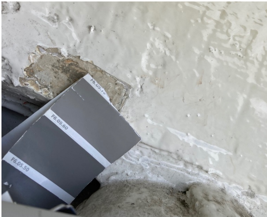
De eerste verflaag op het houtwerk van de timpaan matcht bij benadering met kleurcode F6.05.60
