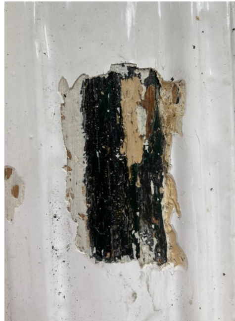
Sondering op deurstijl. De eerste afwerking is een zachtgele kleur op een witte grond. Daarna volgen 3 zeer donkere afwerkstadia, vervolgens enkele in gebroken wit
