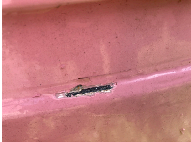
Sondering waarin een oude, zeer donkere afwerklaag zichtbaar is
