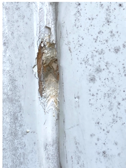
Punctie in groef tussen vlak deel en profiel
