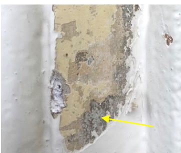
Sondering: grijze laag (pijl) gevolgd door twee gele, dan roomwit
