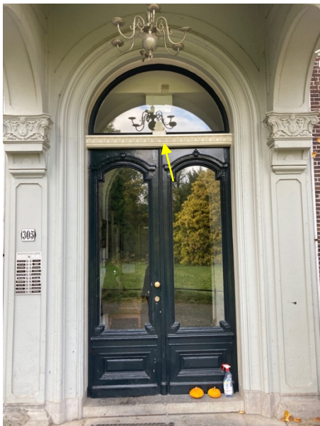
Huidige voordeur in de oostgevel
