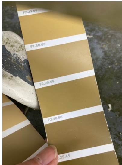
Onder resp. de huidige crèmewitte en een blauwgrijze verflaag is nog een oudere okergele afwerking aanwezig, verwant aan de afwerking van de rechter ijzeren veranda aan de oostgevel
