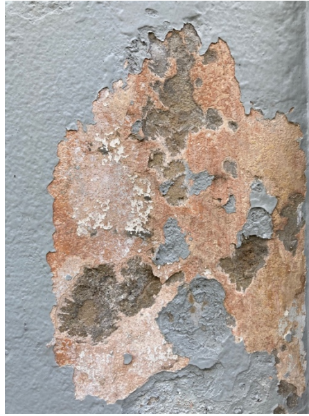
Dezelfde verflagen als op primaire onderzoekslocatie, hetzij minder compleet / aangetast
