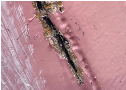
Andere punctie waarin donkere laag zichtbaar is
