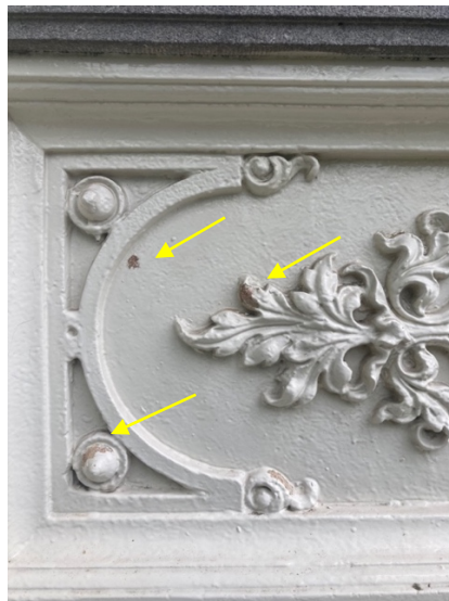
Onderzoeklocaties (sonderingen) op de borstwering
