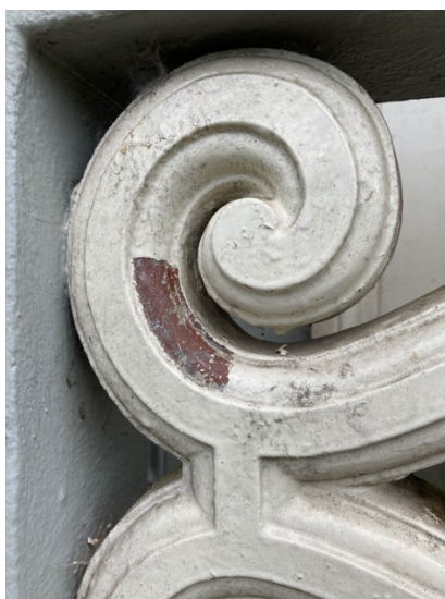
Op de gietijzeren elementen is dezelfde bruinrode laag aanwezig als op de balustrade van het balkon
