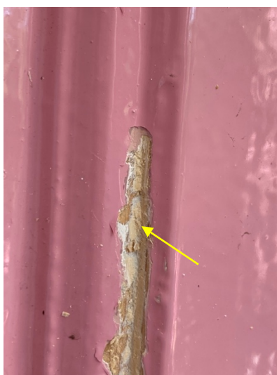
In een groef tussen paneel en profiel is nog een fragment aanwezig van een eerdere verfafwerking: lichtgeel
