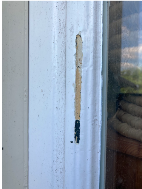
Kleurtrap op deurstijl: lichtgeel, sterker geel en diep donkergroen
