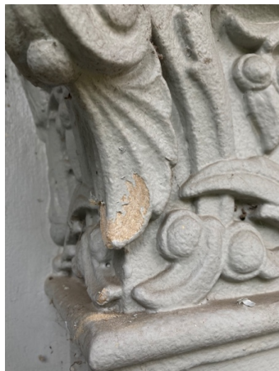
Sondering op bladmotief van kapiteel. Er zijn slechts restanten van één vroegere verfwerking in een bruingelige laag
