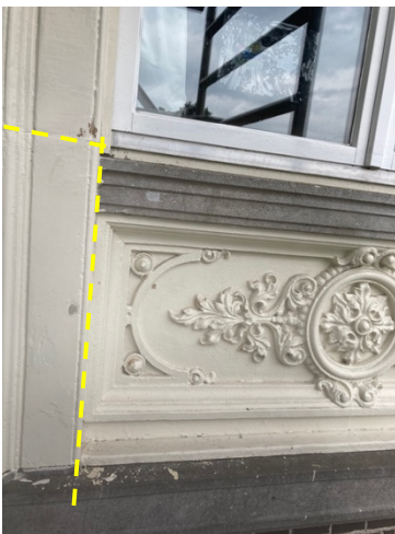
Stenen deel van raamomlijsting
