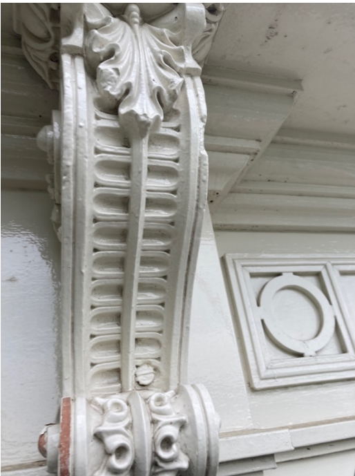
Terracotta sierconsole aan de noordgevel
