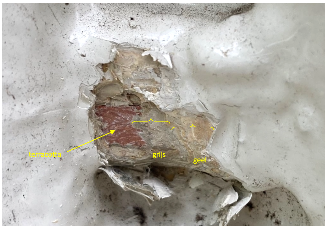
Punctie op sierconsole. Op de roodbruine terracotta drager eerst een serie grijze verflagen, gevolgd door een opeenvolging van gele lagen. De meest recente lagen zijn grijswit en roomwit
