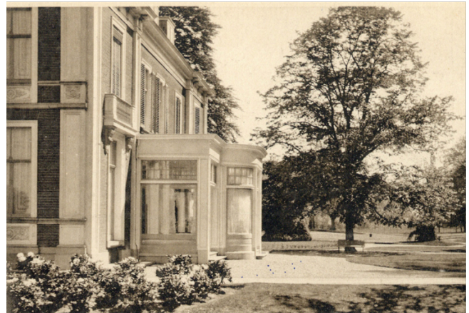
Foto van de westgevel met in 1916 (bouwfase 7) gebouwde serre (1920-1930)
