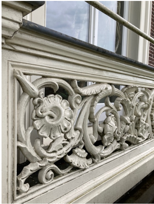
Balkon balustrade met gietijzeren ornamenten
