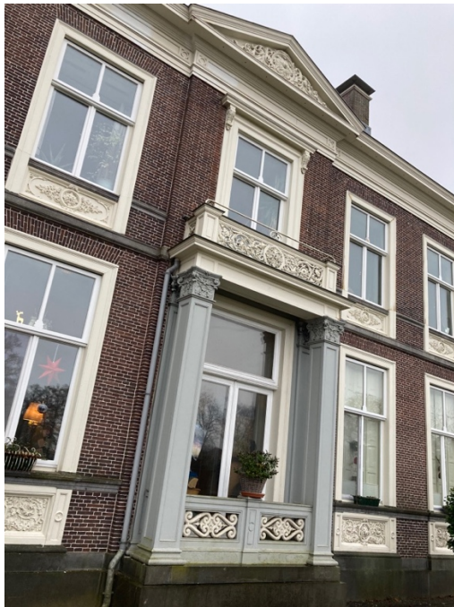
Raampartijen aan noordgevel; gewijzigd, verlengd en met terracotta decoraties verfraaid in bouwfase 3 N.B. Vensters vervangen bij verbouwing in 1989-1991
