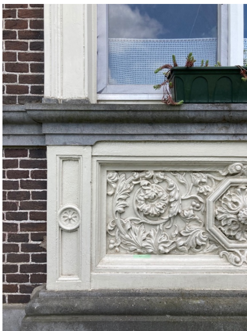
Onderkant raampartij op begane grond-niveau Doorlopende stenen vensterbank/waterlijst Gepleisterde borstwering met ventilatieroostertje en terracotta ornament invulling
