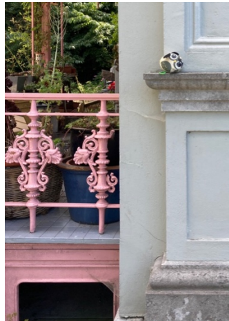
Detail van onderkant van veranda: Ijzeren basis, balusters, terracotta versieringen (krullen)
