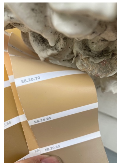
Oker (warm)gele verflaag: ca E8.25.65
