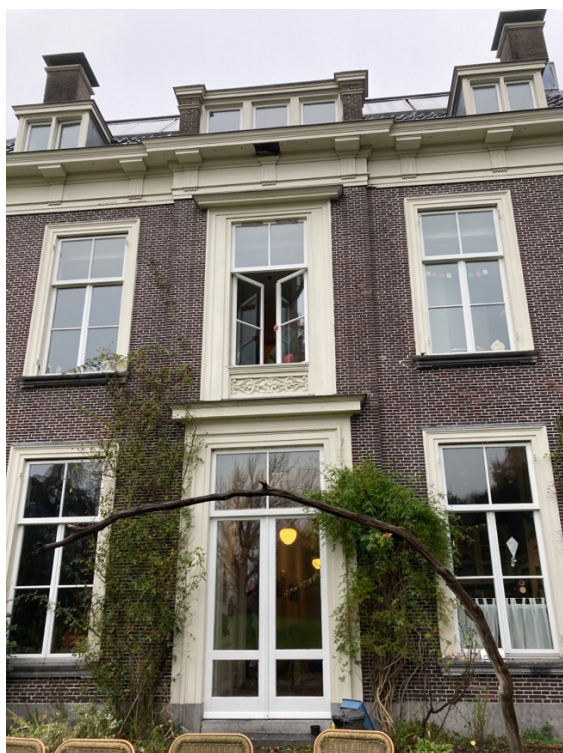
Zuidgevel met eenvoudiger raampartijen
