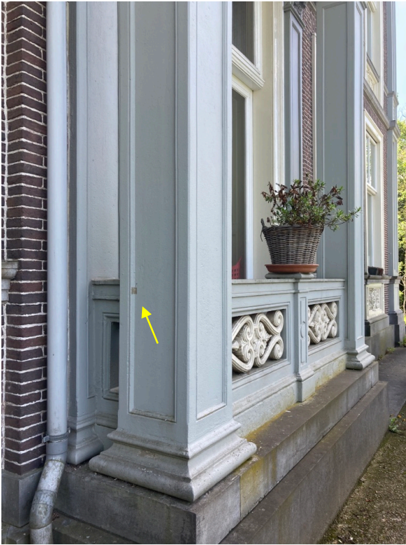
Hoekpilasters van de deuroplijsting: onderzoekslocatie
