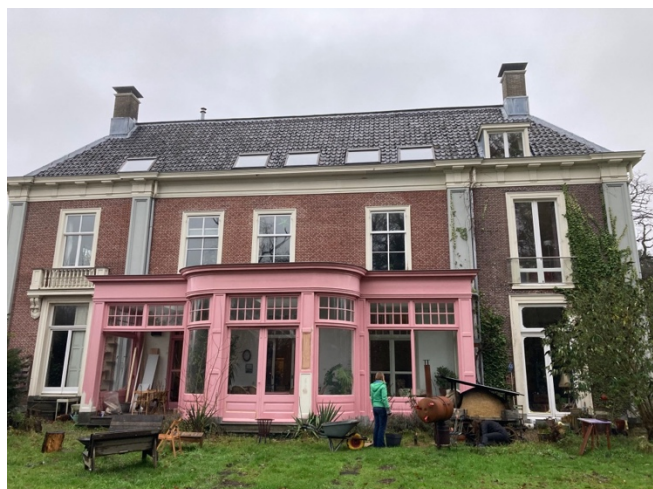
Westgevel met eenvoudiger raampartijen; de huidige vorm alsmede het Franse balkon (links) dateert uit bouwphase 3 (1846)
