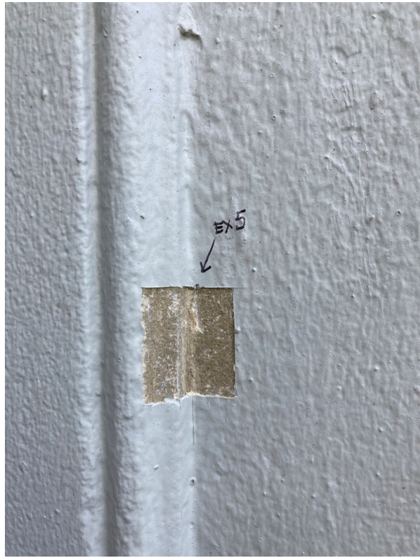
Stratigrafisch onderzoek op overgang van vlak deel naar profiel. Alleen in het hoekje zijn fragmenten van enkele oude verflagen bewaard gebleven; geel- en bruinig van kleur
