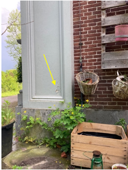
Hoekpilaster westgevel (links)
