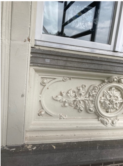
Borstwering met sierelementen van terracotta (raam op verdiepingsniveau)
