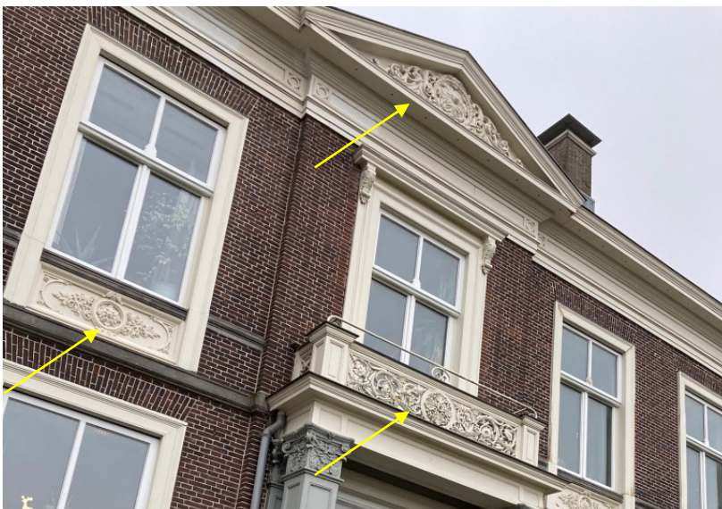
De timpaan heeft een invulling met een houtgesneden ornament dat qua datering en stijl/vormgeving gelijk is aan de keramische gevelversieringen van borstweringen en balkon
