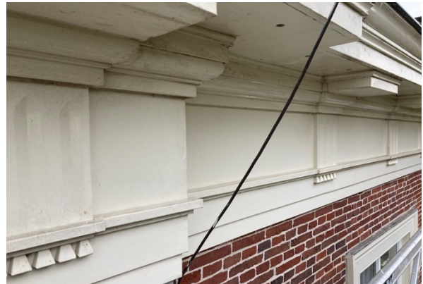
De daklijst aan de westgevel is voorzien van triglif-ornamenten zoals in de oorspronkelijke situatie, maar al het hout is vervangen in de late 20 ste eeuw
