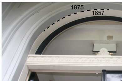
Entreedeur waarin twee bouwfases te zien zijn.
