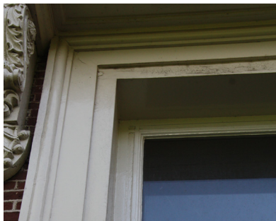
Recht kozijn met toognagel, kozijnlijst met kwartrond profiel. (1991) Bovenlicht met terugliggende lijnen (hoort mogelijk bij de dubbele deur in de voorgevel, zie pag 26).
