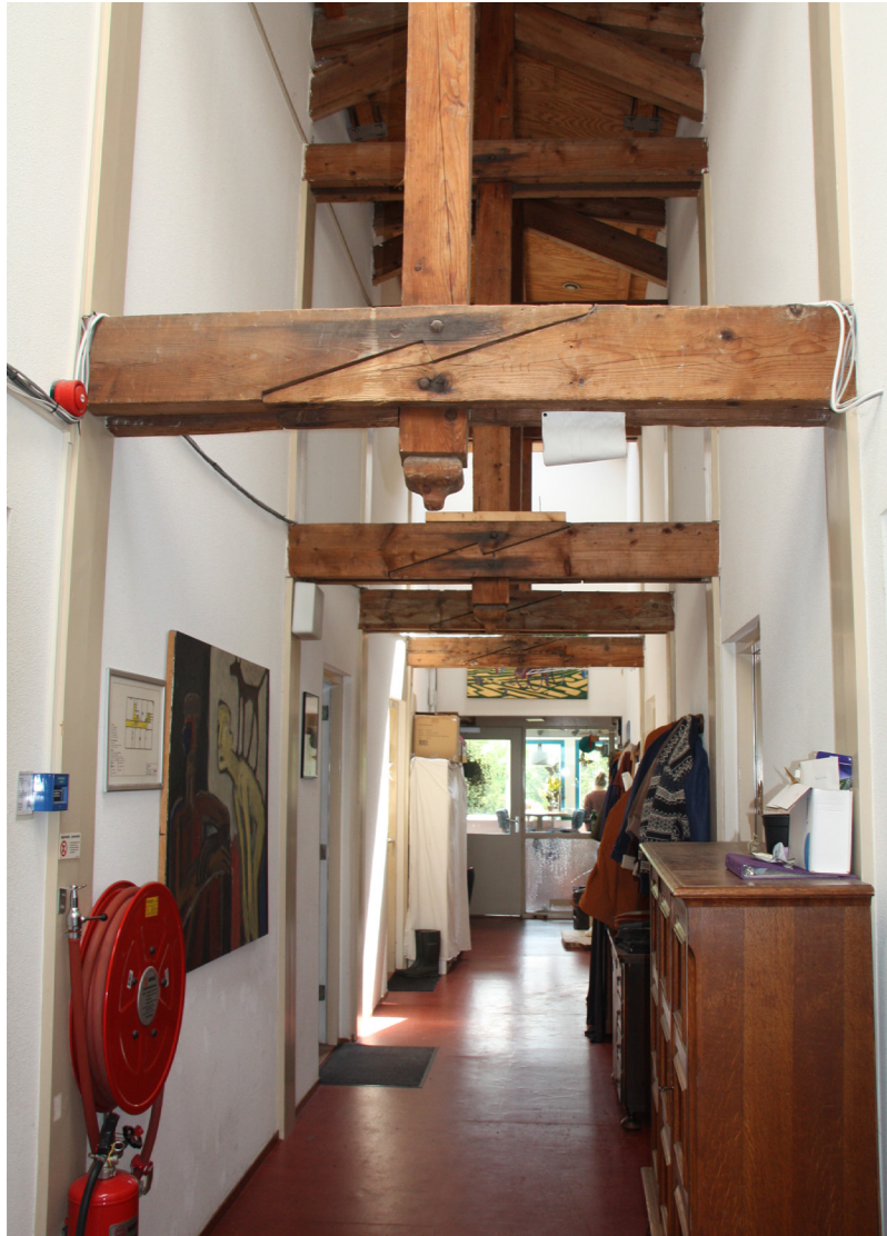
Tweede verdieping, kapconstructie ter plaatse van de gang.
