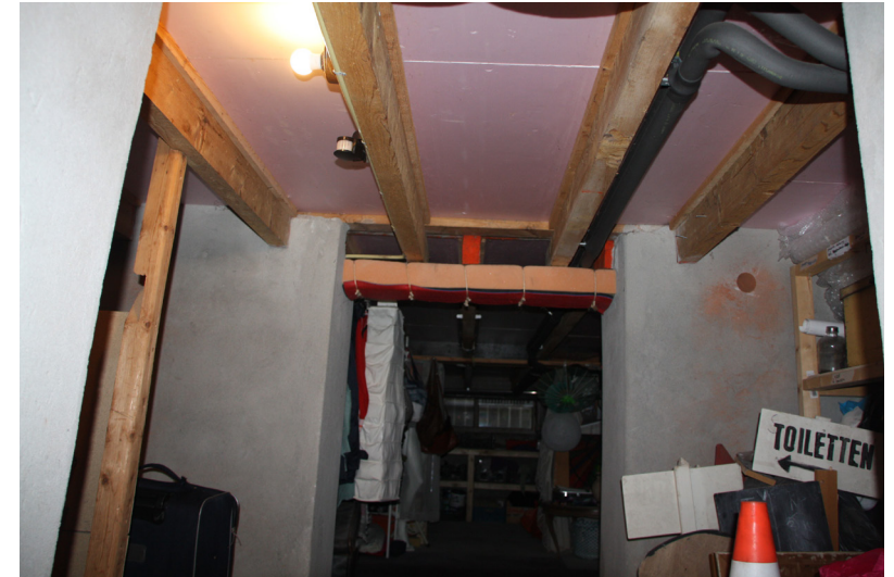
kelder met vernieuwde begane grondvloer, gezien richting de rechter zijgevel
