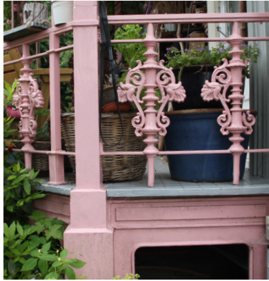
Veranda met gietijzeren constructie en terra cotta decoratie.
