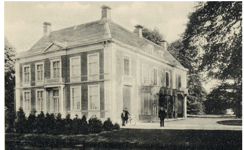
Voorgevel en rechter zijgevel, ca 1895-1900 (bron: beeldbank HUA)
