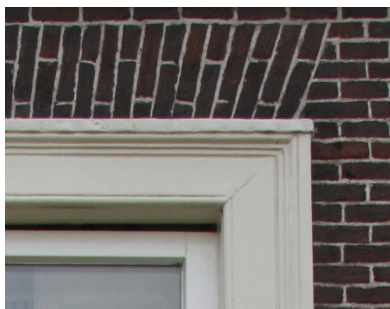
Vensteropening met strek, kozijn met kraal, kozijnlijst met ojiefprofiel. (1846) Raam is vernieuwd. (1991)
