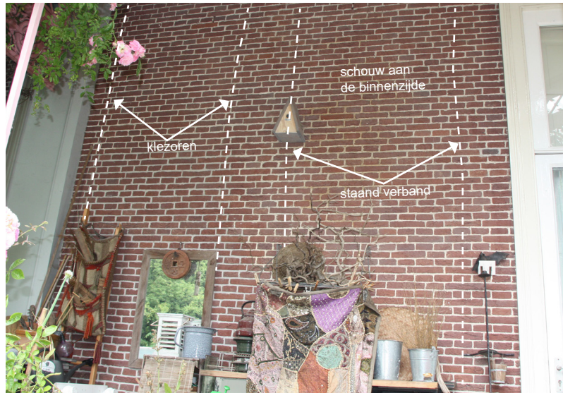
Detail van het onregelmatige metselwerk achter de veranda.
