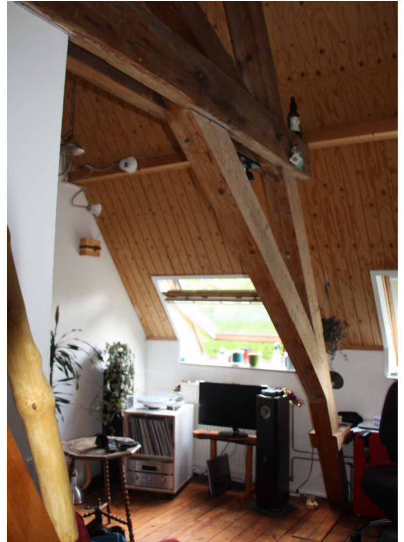
Spantbenen, dubbele trekbeamben en verbinding door middel van bouten en vierkante moeren.
