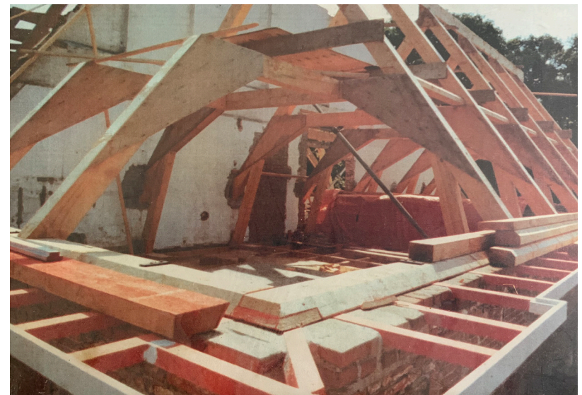
Foto tijdens de restauratie, de kap van de voorste beuk wordt vervangen. (bron: huisarchief)
