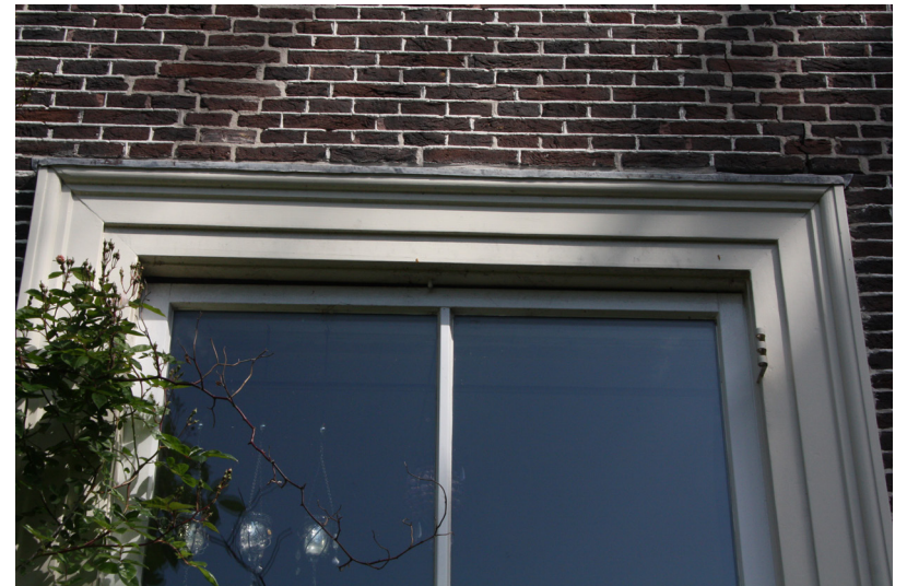
Vensteropening zonder strek, recht kozijn, kozijnlijst met kwartrond profiel, vernieuwde ramen (1991)
