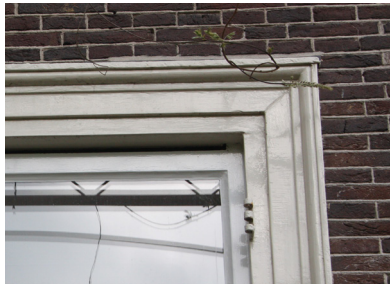
Vernieuwd venster in het middelste geveldeel.
