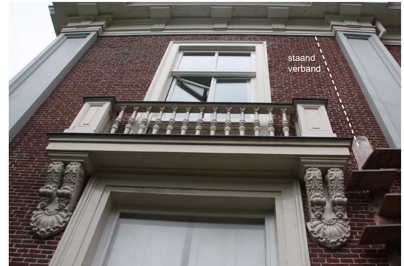
Linker geveldel met Frans balkon (1846)
