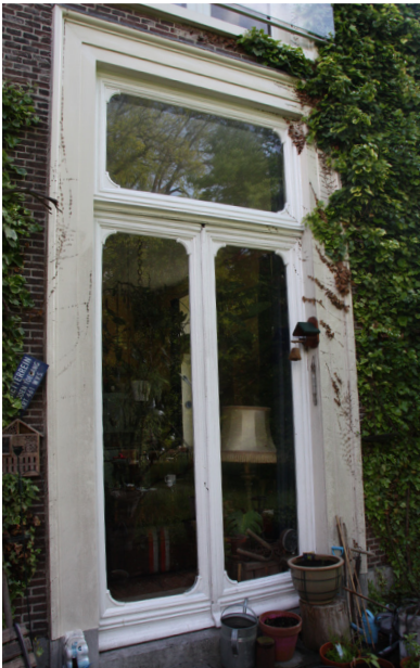
Tuindeur in het rechter geveldeel.
