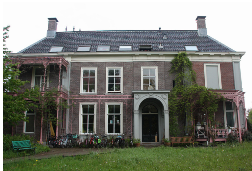
Linker zijgevel, met de hoofdentree.
