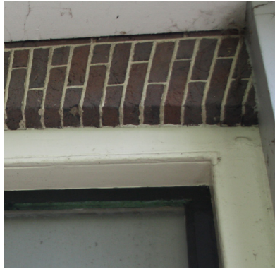
Deuropening met strek, kozijn met kraal in het linker geveldeel (1846)
