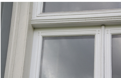
Tuindeur met kozijn zoals bovengenoemd, dubbele deur met terugliggende lijnen (hoort mogelijk bij het bovenlicht in deuren in rechter zijgevel, zie pag. 28).
