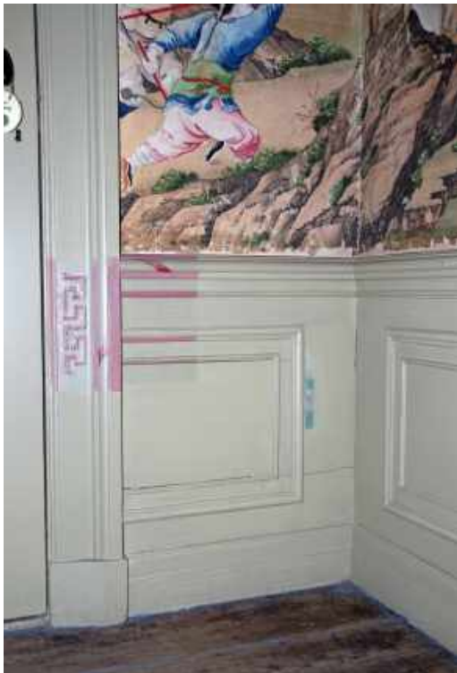
224 Detail van roze-rode meanderbeschildering, vrij gelegd en gereconstrueerd op de betimmering; afwerking behoort bij oudste beschilderde wandbespanning (Lodewijk XVI); kozijn en lambrisering bij rechter deur in noordwand.
