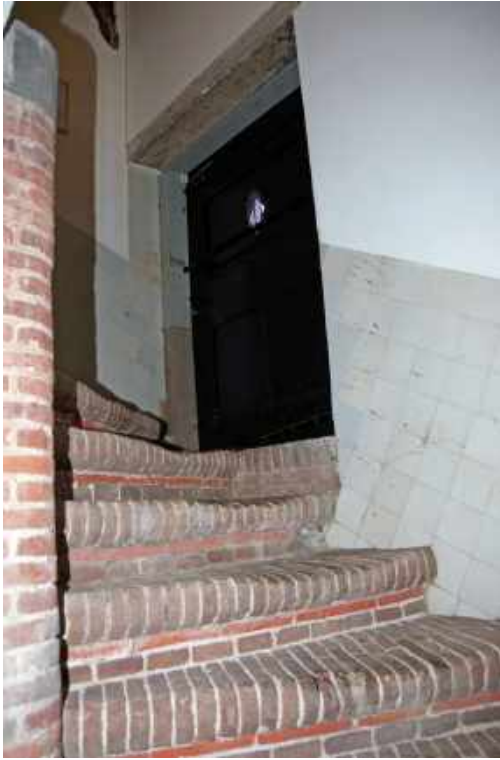
150 Trapportaal (0.16) met dienstingang in de westgevel, gemetselde trap en lambrisering van witte tegels.
