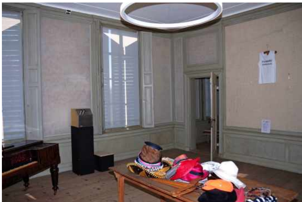
300 Vertrek 1.9, Roze appartement, gezien in zuidwestelijke richting. Deur naar vertrek 1.10 in enfilade.
