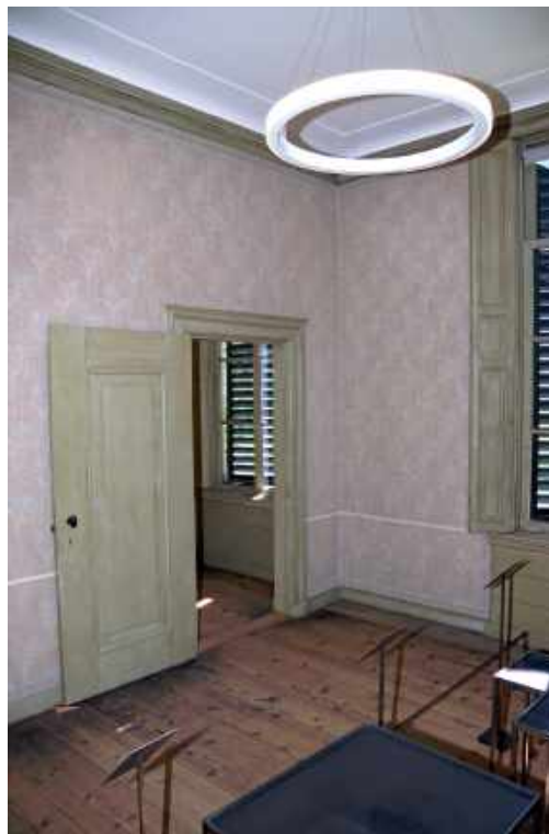
314 Vertrek 1.13, gezien in zuidoostelijke richting, met deur in enfilade naar kabinet 1.12. Onder het venster een betimmering.
