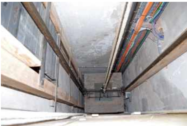
342 Zicht in liftschacht met liftkooi.
