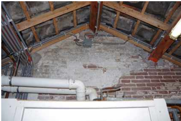
264 Berging met ziende kap, aangebouwd tegen de bijkeuken; metselwerk is deels gepleisterd.
