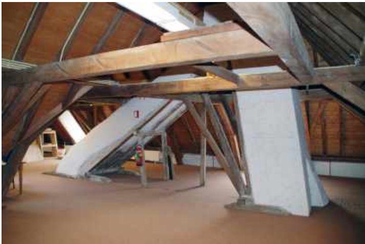
124 De zolder van huis Eerde met links het deel van de beschoten kap dat naar de zakgoot leidt en rechts de versleepte schoorsteenkanalen. Het schoorsteenkanaal in het midden is van de keuken in het souterrain. (Foto 2013)
