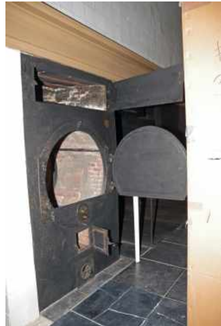
170 Waterstookketel met bovenin warme-houdkast, links in de keukenschouw.
