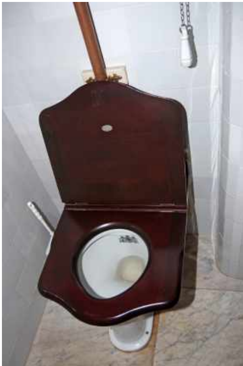
189 Inrichting watercloset, 1921; toiletspot met houten bril en deksel.
