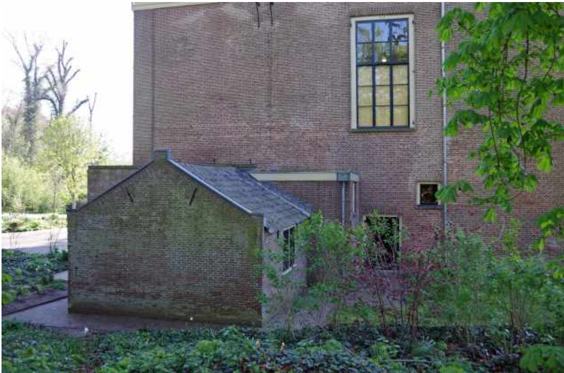
7 Deel van de westgevel met bijkeuken en schuur en rechts daarvan de dienstingang.
