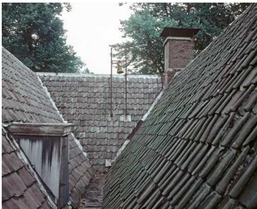
113 De zakgoot rond 1975 in zijn oorspronkelijke toestand. (Herkomst: Beeldbank HUA; Foto H. de Wijs)
