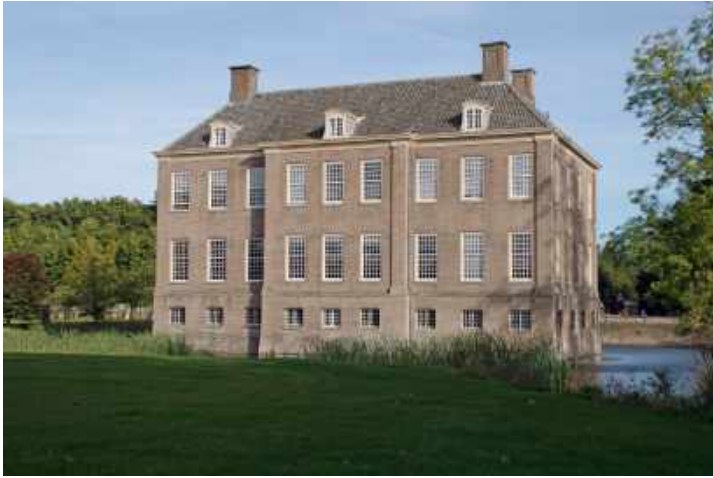
123 De achterzijde van huis Eerde uit 1715 dat iets groter is dan Oud-Ameliweerd en geheel voorzien van een souterrain, maar verder een vergelijkbare opbouw kent. (Foto 2013)
