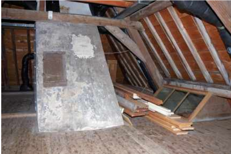
358 Rookkanaal met veegluiken in de noordoosthoek (hoekpaviljoen) met rechts koekoek met legraam van dakkapel (boven meidenkamer 2.5).
