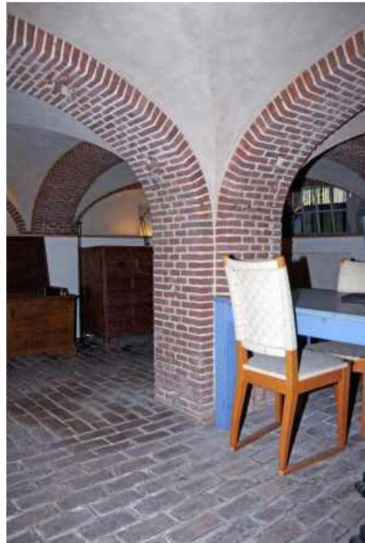
33 De vierkante kelder in het noordwesten (-1.1) met ribloze kruisgewelven en gordelbogen op middenkolom.
