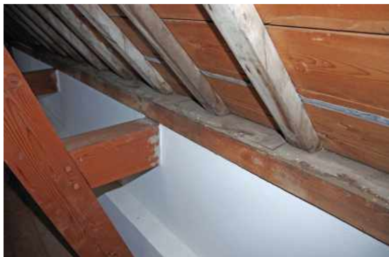
323 Korbelen en muurplaat, waarop sporen met dakbeschot van de kapconstructie.
