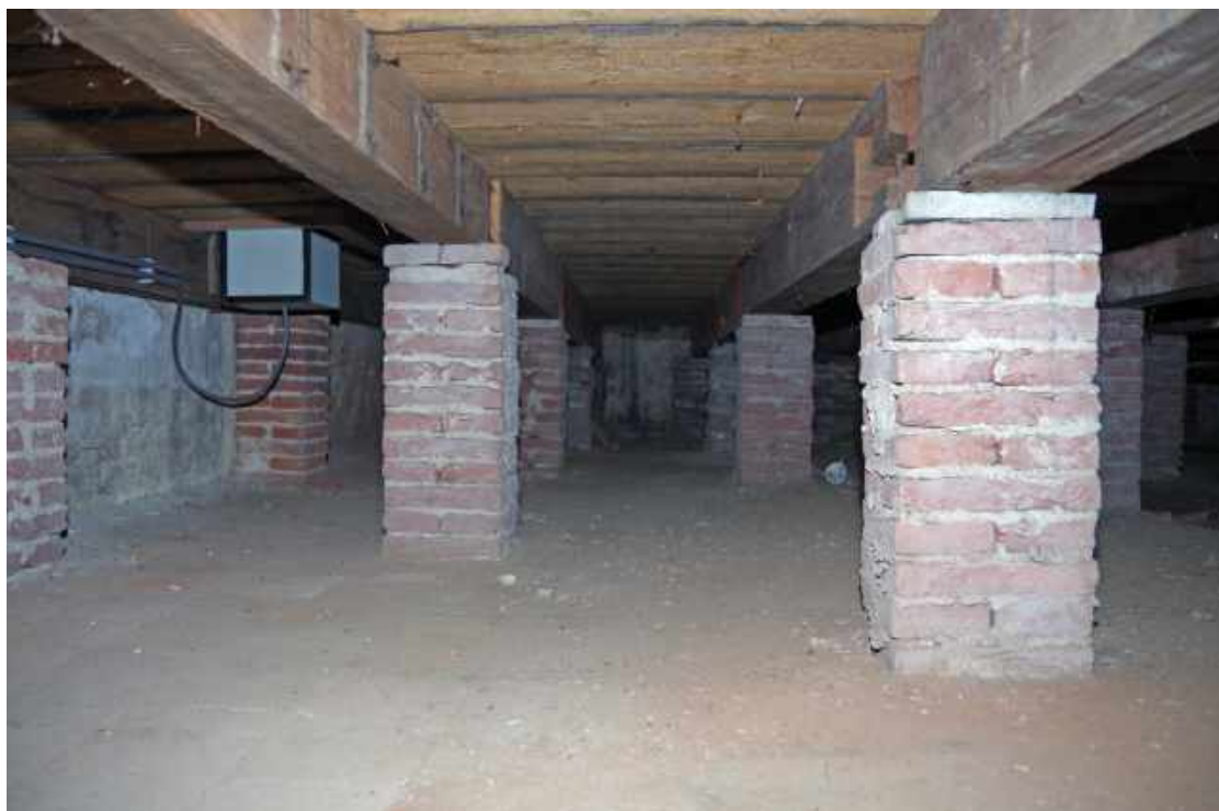
157 Kruipruimte onder de Vogeltjeskamer (0.9) met tegelvloer, gepleisterde noordwand en hergebruikte balken.
