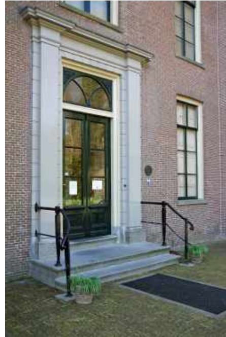
6 De omlijste ingang. De rechthoekige 'mat' voor de deur is een liftplatform voor mindervaliden.
