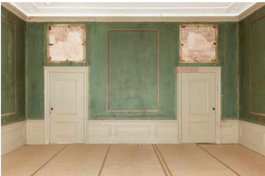
61 Het oorspronkelijke groene behang op de noordwand van de Chinese salon (0.10) met geschilderde architectonische lijsten. (Herkomst: Beeldbank RCE, foto 2013)
