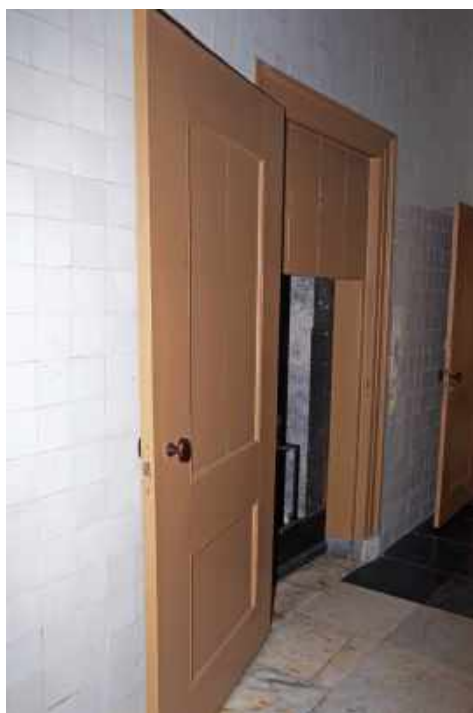
165 Turfhok onder de trap, gezien naar het westen.
