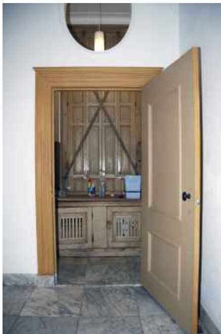
175 Toegang tot provisiekamer met marmeren plavuizenvloer, houten aanrecht met provisiekastjes en vouwluik voor het venster.
