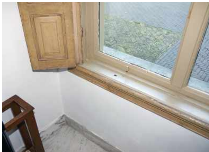
184 Venster in de noordgevel met vouwluiken.
