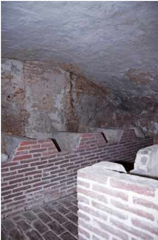
32 Kelder met tongewelf (-1.2), gezien naar het zuidoosten, met een wand met grotere baksteen en daarin een dichtgezette opening.
