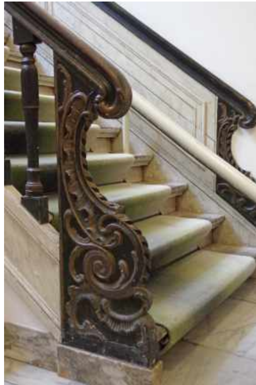
236 Detail beginbaluster (trappaal) in Lodewijk XV-stijl.
