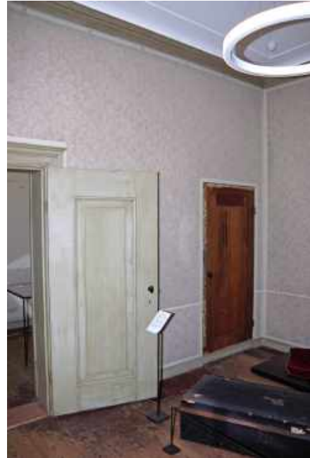
306 Vertrek 1.11, kabinet van het Groene appartement, gezien naar het noordwesten, met links deur in enfilade naar vertrek 1.12 (kabinet van Donkergroene appartement). De houten deur rechts, onderdeel van een sluisdeur, was een verholen deur met bespanning, naar de gang (1.16).
