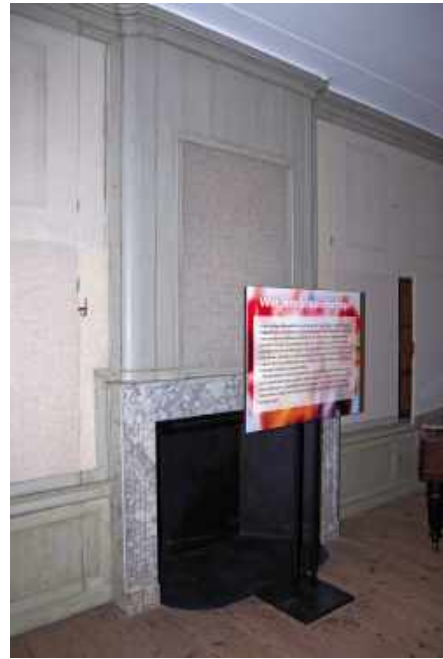
298 Marmeren schoorsteenmantel uit de bouwtijd in de zuidwand van vertrek 1.9.
