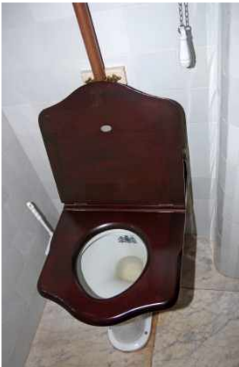
90 Watercloset met houten bril en deksel en porseleinen pot. Rechts de trekker voor de stortbak.
