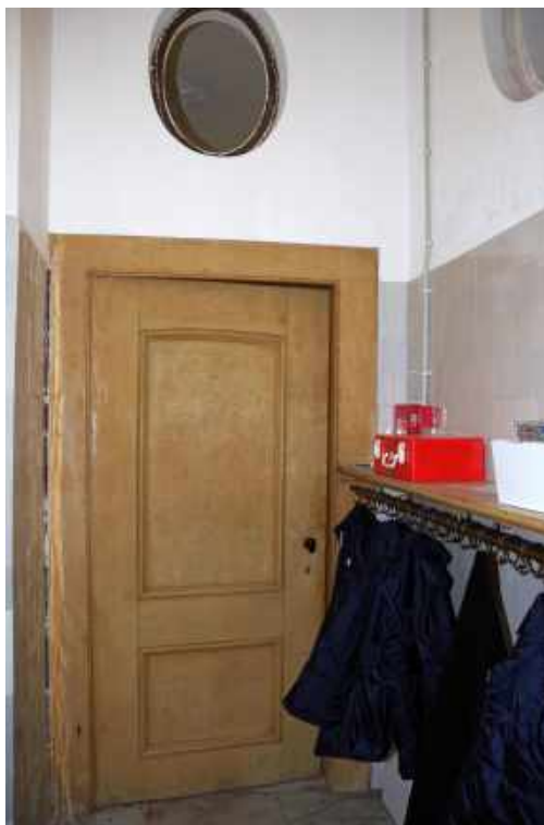
246 Dessertkamer, gezien naar het westen. De deur geeft toegang tot het trappenhuis (0.12).
