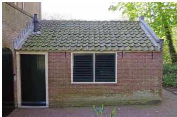
146 De aangebouwde schuur (1.19), gezien vanuit het noorden.
