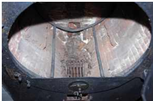
171 Gemetselde binnenzijde van de stookketel met asrooster.
