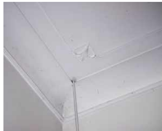
182 Detail hoekornament stucwerkplafond vestibule.
