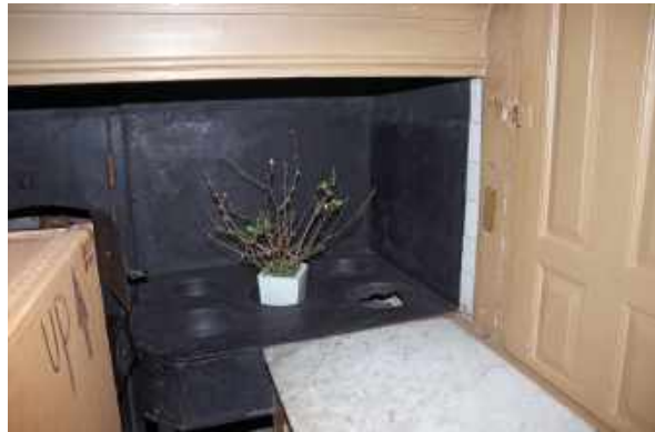
168 Rechts marmeren blad aan de noordzijde (wand c) met schouw en fornuis in de hoek.
