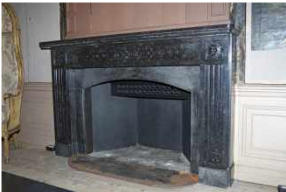
117 Schouw in de Oud-Hollandse kamer (0.13) met uitblaasopening volgens het principe van conservation heating .
