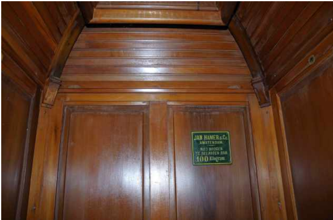
94 Detail van de houten liftkooi met het fabrieksmerk van Jan Hamer & Co.
