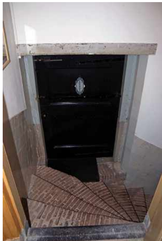
250 Trapportaal naar de kelder, met dienstingang.
