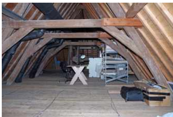
353 Noordelijk deel van de vliering, gezien in oostelijke richting.
