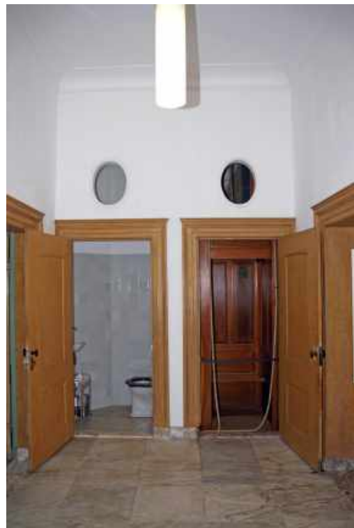
13 De wc (links, 0.6) en de handbediende lift (rechts, 0.7), die in 1921 in het landhuis werden aangebracht.
