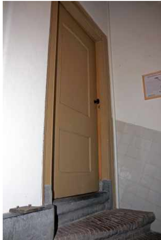
249 Trapportaal met deur naar trappenhuis 0.12.
