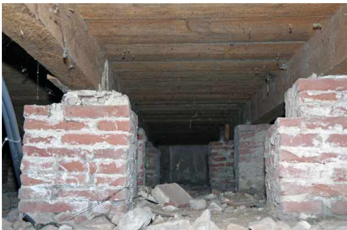
158 Kruipruimte onder de Chinese Salon (0.10), volgestort met puin.
