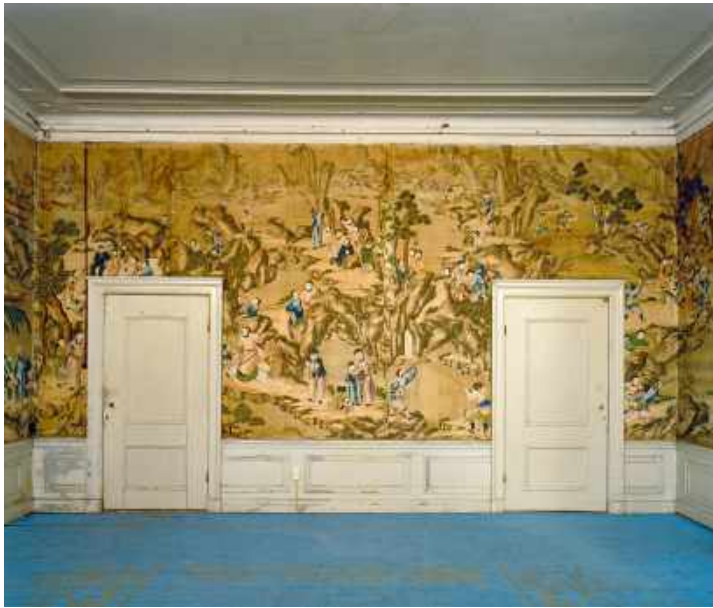
62 Het Chinese behang op de noordwand van de Chinese salon (0.10). Duidelijk zichtbaar is dat de deuren niet goed in de lambriering passen en door de voorstelling heen snijden. (Herkomst: Beeldbank RCE, foto 1991)
