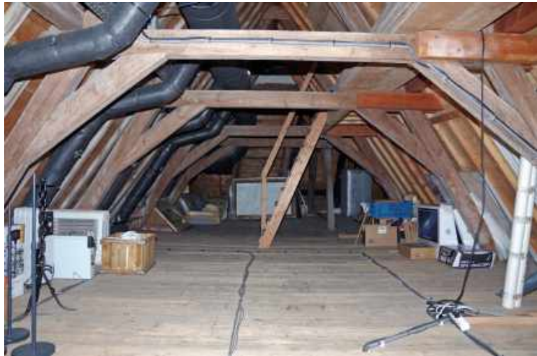
349 Zuidelijk beuk van de vloering, gezien in westelijke richting. Achterin ladder naar zakgoot.
