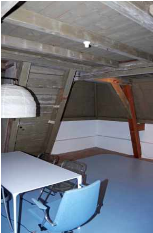
344 Meidenkamer 2.9, met een van de rookkanalen.
