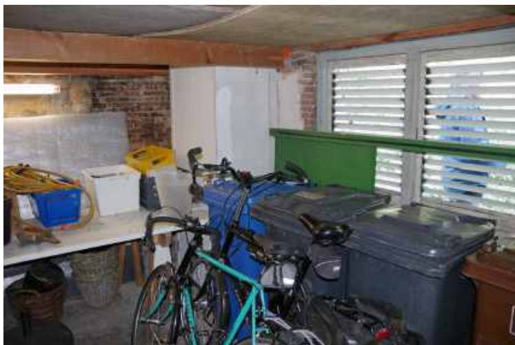
265 Berging met lamellenroosters in de vensteropeningen ten behoeve van de ventilatie.
