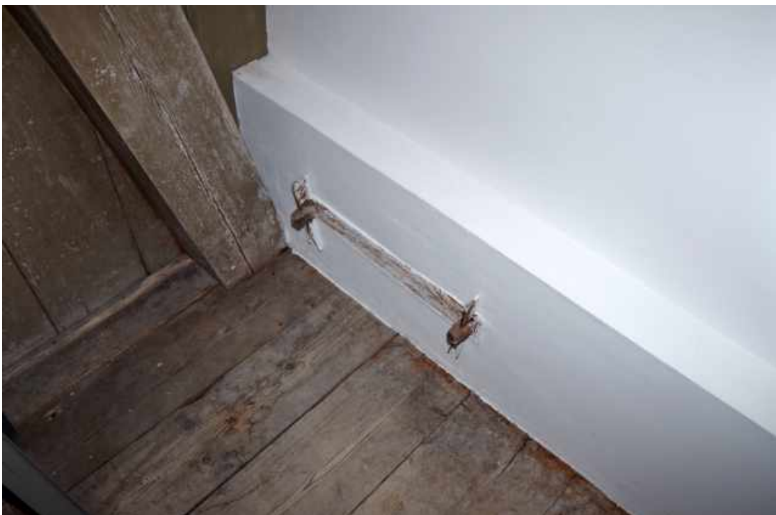
78 Ankers voor de klokkenstoel aan de westgevel.
