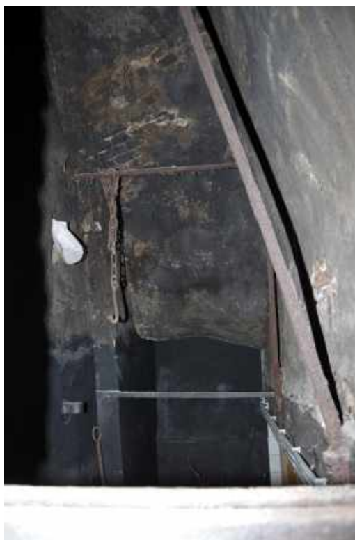
174 IJzeren stang met haak aan ketting voor het roken van worst.
