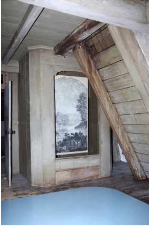
22 Een van de drie meidenkamers op zolder met een deel van de kapconstructie en een bedstede.
