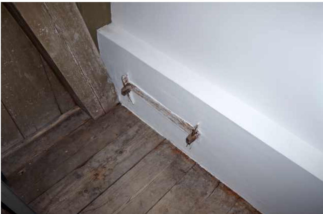
332 Anker ter bevestiging van de klokkenstoel aan de westgevel (wand b).
