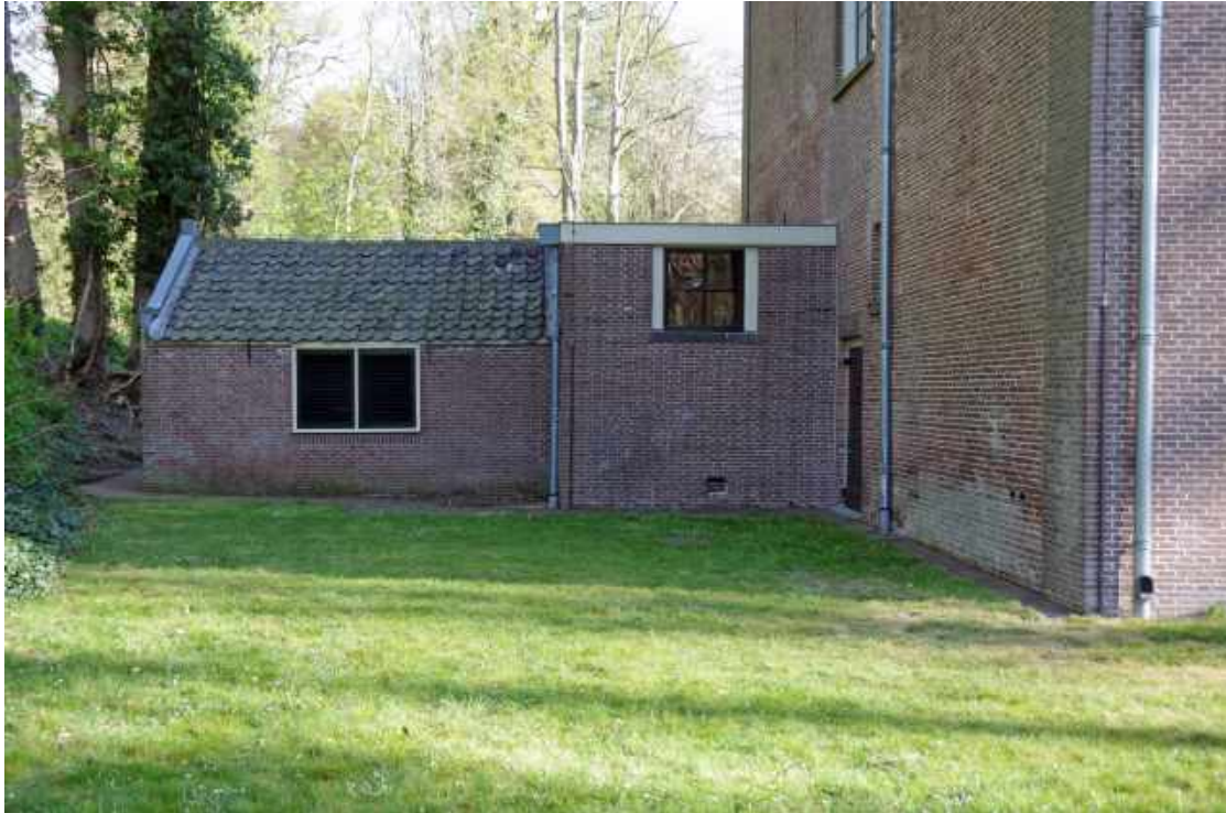
144 Aanbouw aan de westzijde, gezien vanuit het zuiden.
