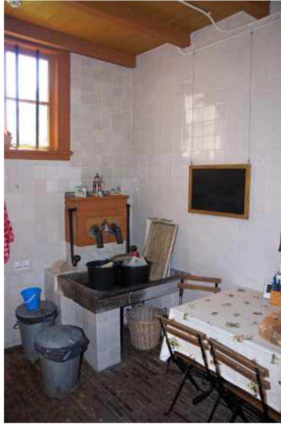
15 De zuidwestelijke hoek van de bijkeuken (1.17) met de dubbele pomp.
