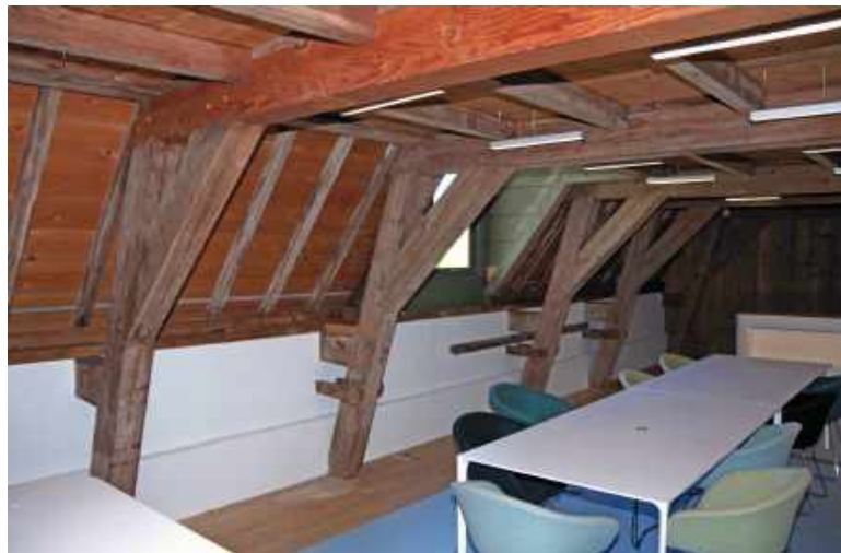
322 Detail onderste spantbenen van de kapconstructie.
