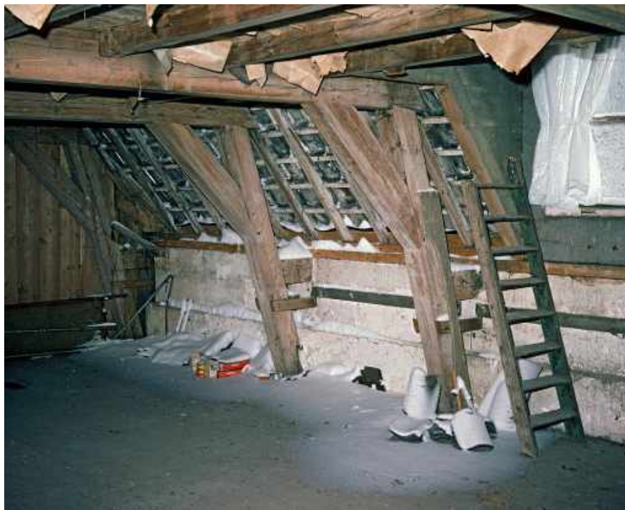
112 Deel van de onbeschoten kapconstructie op zolder met doorgestoven stuif-sneeuw in de strenge winter van 1963. (Herkomst: Beeldbank HUA; Foto H. de Wijs)
