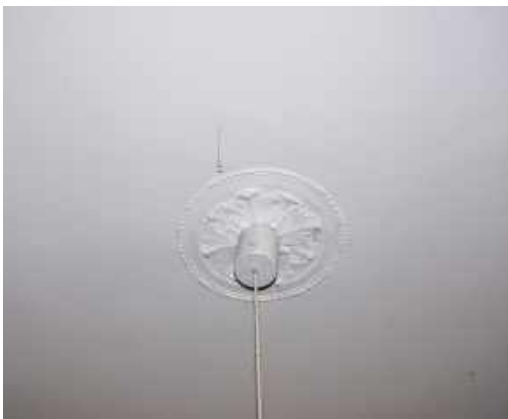
181 Detail middenrozet stucwerkplafond vestibule.
