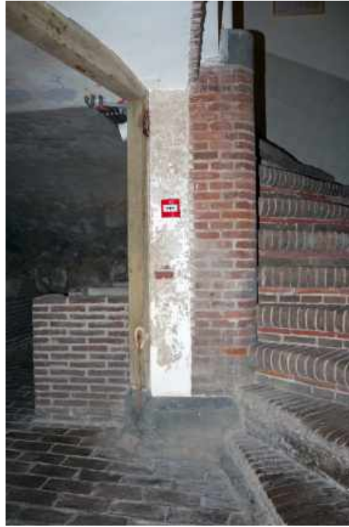
151 Toegang tot kelder (-1.1) met houten kozijn zonder deur.
