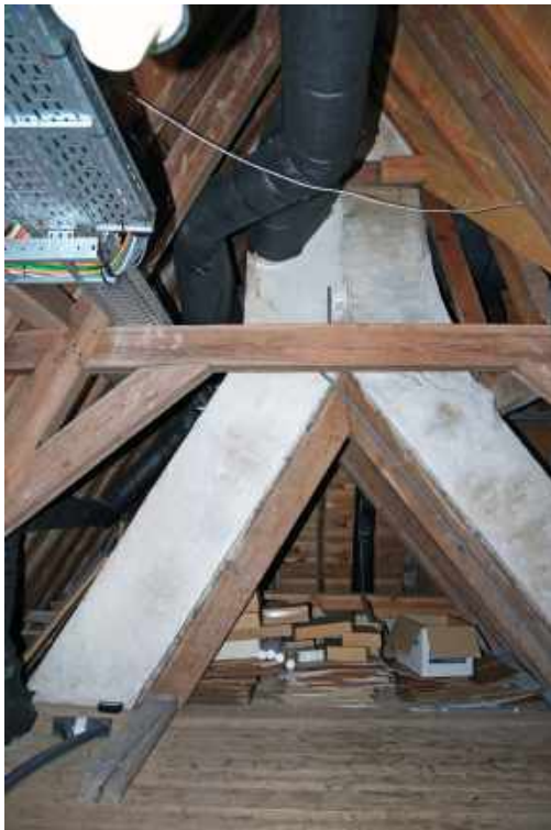
356 Dubbel rookkanaal in de zuidoosthoek van de vliering.
