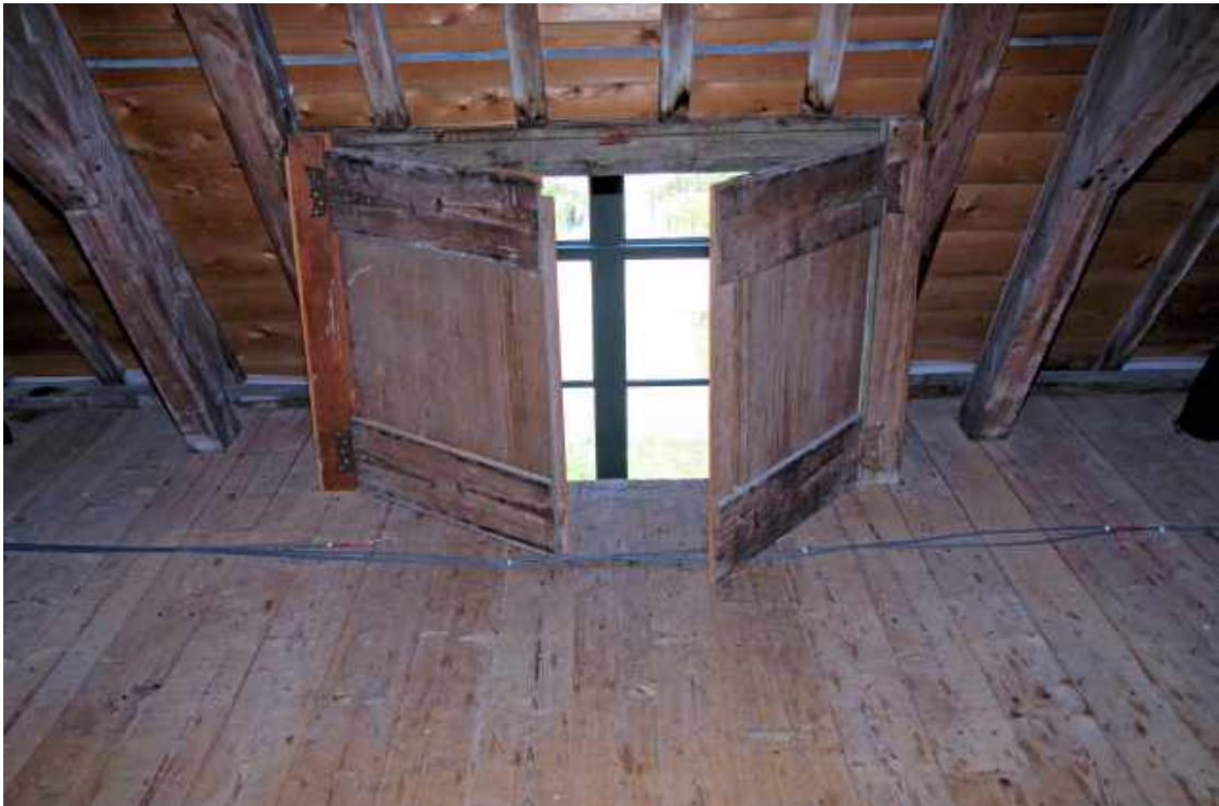
77 Vlieringluik als verbinding tussen de zolder en de vliering aan de zuidzijde.
