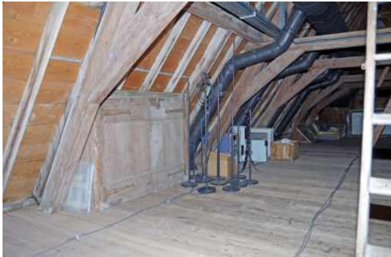
350 Turf(?)kast ter plaatse van de middelste dakkapel aan de zuidzijde.
