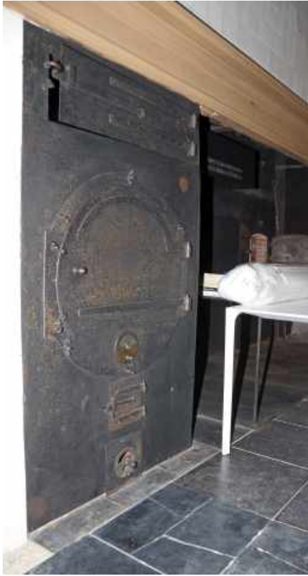
14 Detail van de keuken (0.1) met het gietijzeren deel voor het warme water.
