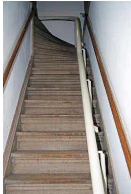
118 De diensttrap aan de westzijde naar zolder met de geleiderail van de stoellift.
