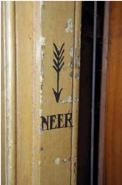
95 Aanduiding op de kozijnpost met de richting waarin het touw getrokken moest worden.
