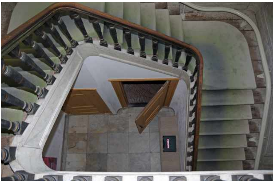
18 Het trappenhuis (0.12 en 1.16), gezien vanaf de omling op de eerste verdieping.
