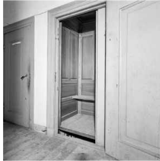
93 De leeggeruimde houten liftkooi van de handbediende personenlift. (Herkomst: Beeldbank RCE, foto 1996)
