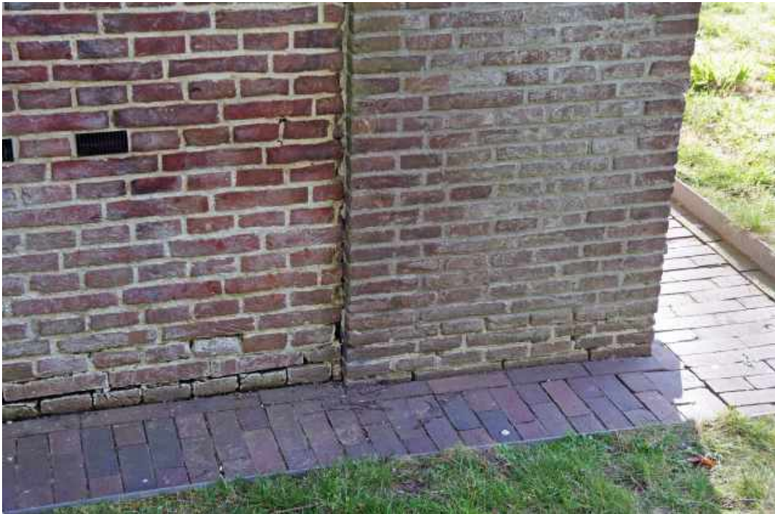
56 Zuidwestelijke hoek met de liseen (rechts) en het lopende muurwerk met een iets grotere baksteen (links). Op de overgang is te zien dat de baksteen van het lopende werk is afgehakt.
