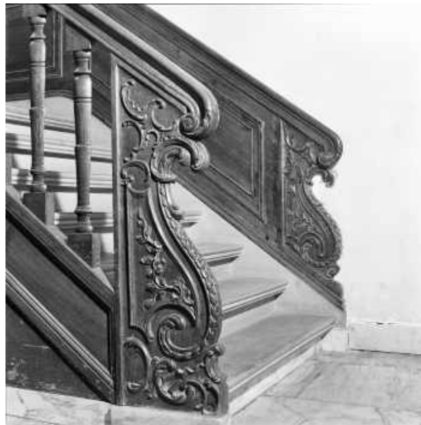
53 Trappaal in rococovormen op de begane grond van kasteel Loenersloot van de verbouwing in 1773-1776. (Herkomst: Beeldbank RCE, foto 1992)
