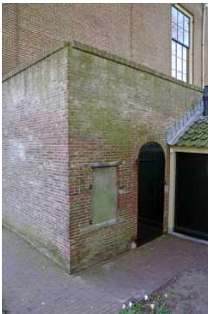
145 Aanbouw met ommuurde binnenplaats, bijkeuken (1.17) en schuur (1.19), gezien vanuit het noordwesten.
