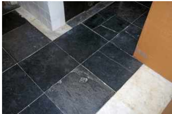
161 Keukenvloer van marmeren en hardstenen plavuizen, bij de schouw.
