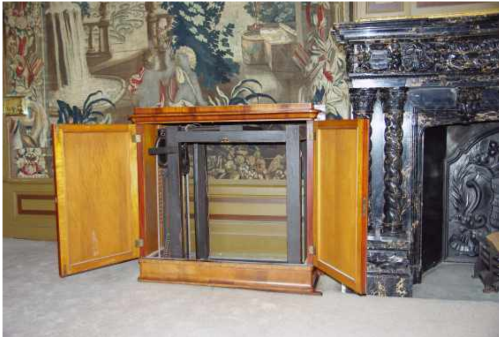
101 Houten opbouw met daarin de constructie voor een etenslift, gemaakt door de firma Jan Hamer & Co, voor de eetkamer van Kasteel Biljoen bij Velp. (Foto 2015)
