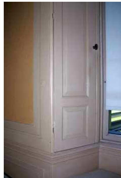
241 Verholen wandkast en luikkast met vouwluiken in diepe vensternis in de zuidwand (wand a).
