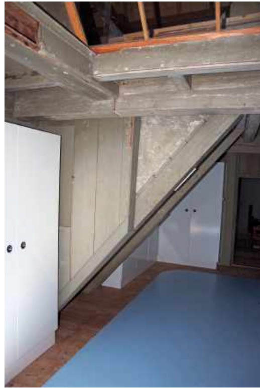
345 Meidenkamer 2.9, met een van de rookkanalen. Via koekoek indirect daglichttoetreding.
