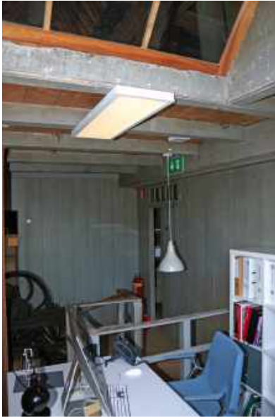
339 Overloop, gezien in westelijke richting, met trapgat en hijsrad van de touwlift.
