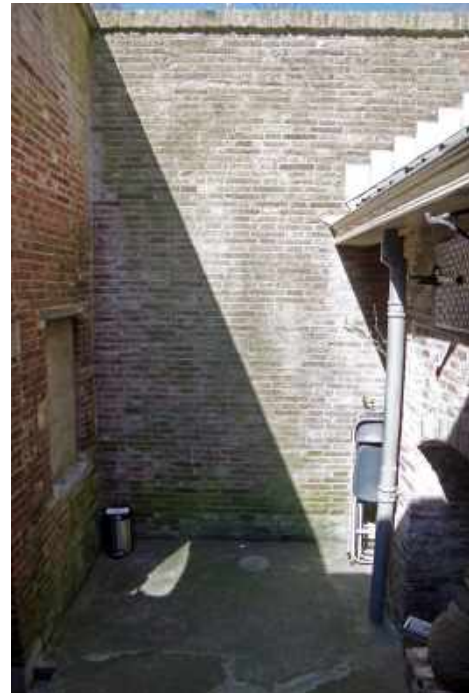
257 Binnenplaats met in de muur een dichtgezette vensteropening. Rechts oven en houtopslag.
