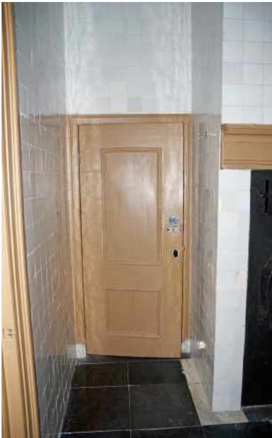
162 Doorgang naar de bijkeuken (1.17), links van de keukenschouw. Hardstenen plavuizenvloer en wit betegelde wanden.
