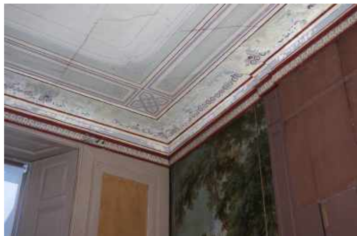
243 Detail polychroom beschilderd plafond uit circa 1890-1900 in de Oud-Hollandse kamer (0.13).
