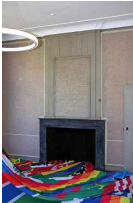
286 Stookplaats met marmeren schoorsteenmantel in de oostwand (wand d).
