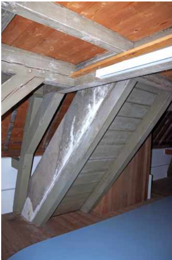
325 Grijs geschilderde spant-benen, balken en betimmering van het rookkanaal in zuidwesthoek. Ter plaatse bevond zich oorspronkelijk de vierde meidenkamer (2.13).
