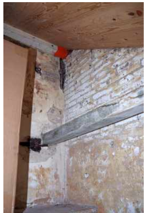
259 In de achterwand van het secret zijn ankers van de rookvang van de keukenschouw zichtbaar.
