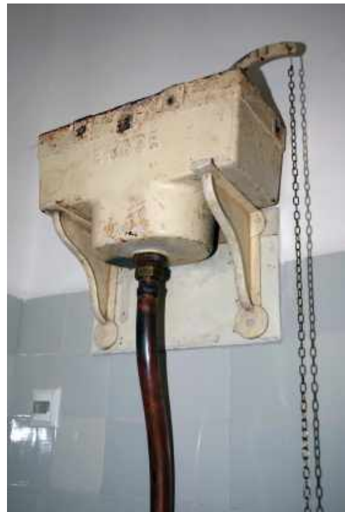
91 Gietijzeren stortbak van het merk EKADE met het jaartal 1921.
