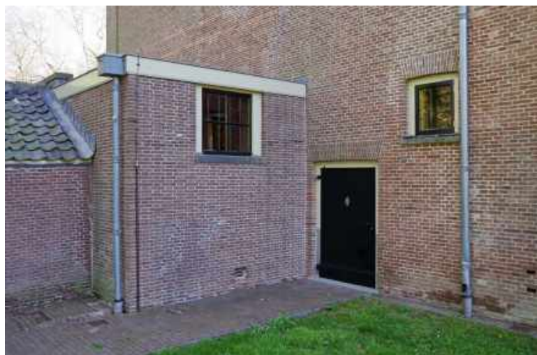
143 Achtergevel (zuidgevel) van de bijkeuken en dienstingang, gezien vanuit het zuidwesten.
