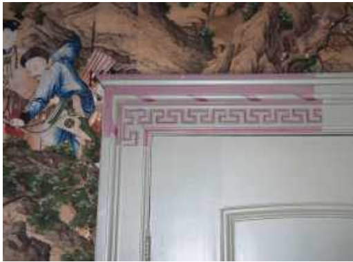
223 Detail van roze-rode meanderbeschildering, vrij gelegd en gereconstrueerd op de betimmering; afwerking behoort bij oudste beschilderde wandbespanning (Lodewijk XVI); kozijn van rechter deur in noordwand.
