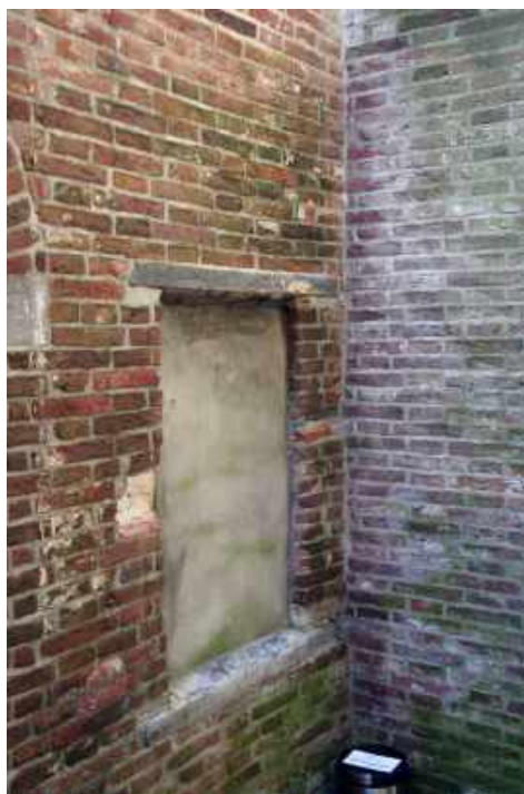
262 Dichtgezette vensteropening met hardstenen latei en dorpel aan de westzijde van de binnenplaats.
