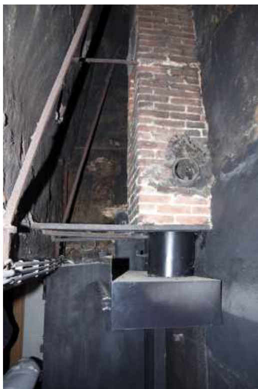
173 Binnenzijde rookvanger van de keukenschouw met later ingemetseld rookkanaal.
