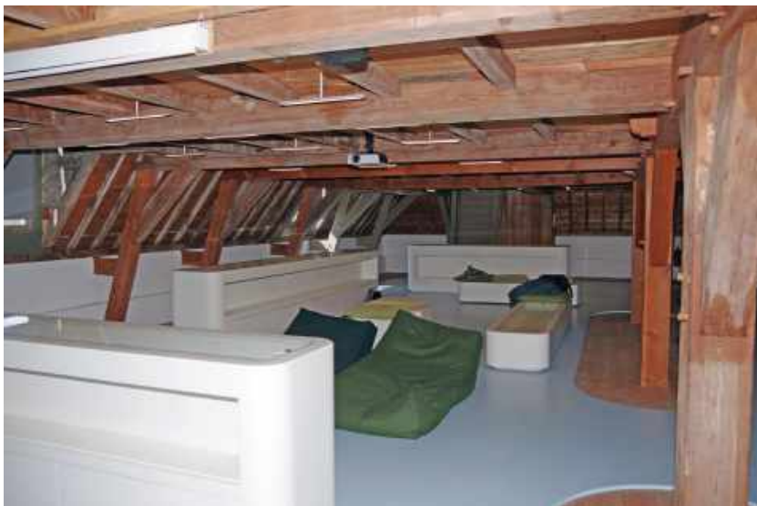
320 Zolder, zuidelijke beuk, gezien in westelijke richting.
