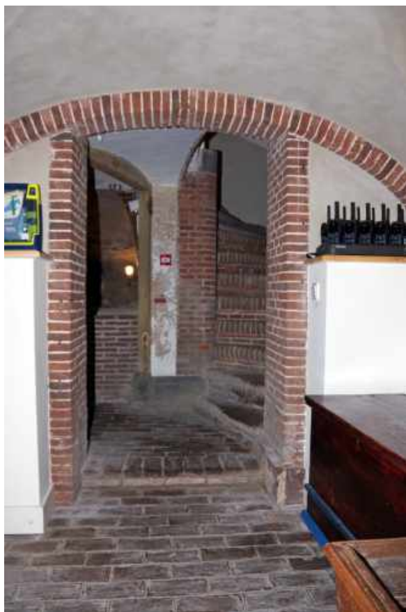
154 Toegang tot kelder (-1.2).
