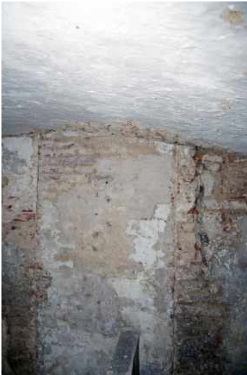
153 Dichtgezette doorgang in oostwand in kelder (-1.1).
