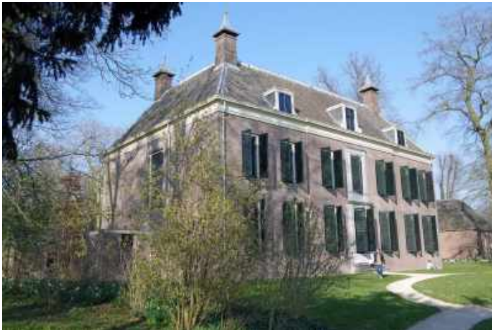
147 Omlopend schilddak, gedekt met gesmoorde Oudhollandse pannen, dakkapellen en schoorstenen met plat dak, gezien vanuit het zuidwesten.
