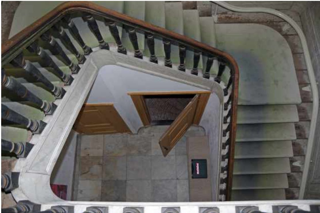
268 Hoofdttrap, gezien naar de bel-etage.
