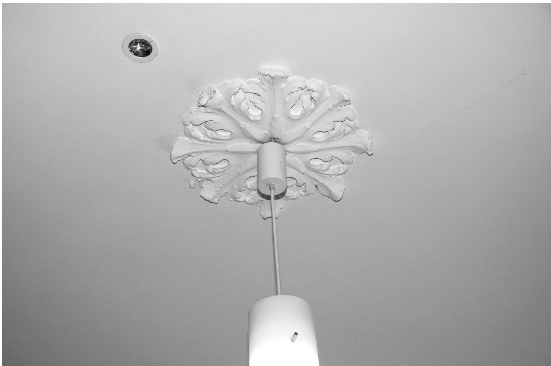
269 Stucwerkplafond met middenrozet in trappenhuis.
