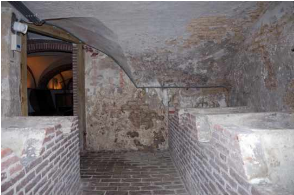
16 Het oudste deel van de kelder (-1.2) met de gemetselde fundamenten voor de vaten.
