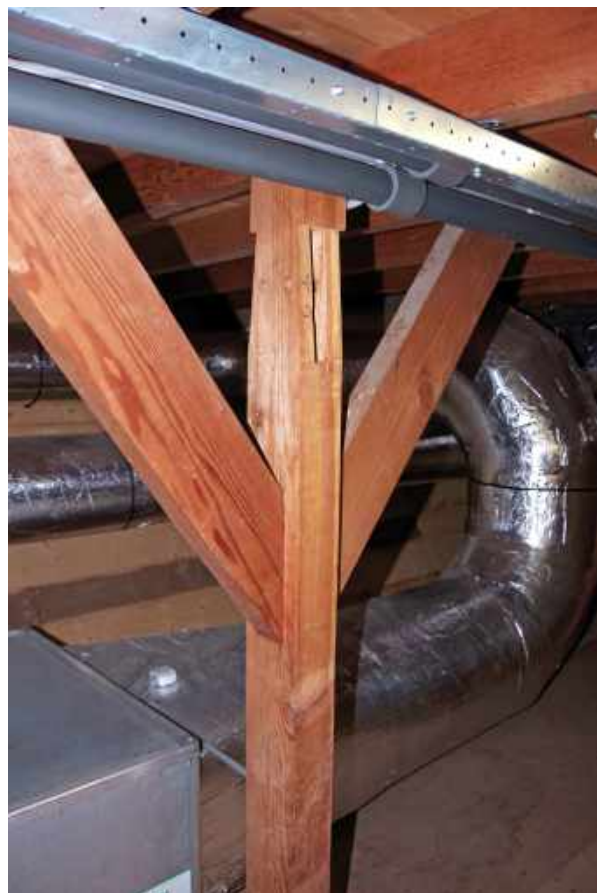
362 Standvink van overkapping zakgoot.
