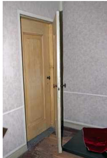
308 Dubbele deur (sluisdeur) in de westwand (b) naar de gang (1.16).
